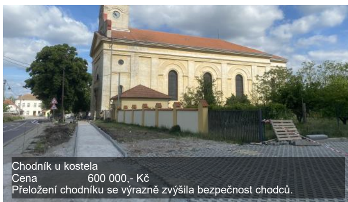
Chodníky Dunajovická, Hlavní, Nádražní Cena 11 300 000,- Kč Dotace 9 400 000,- Kč Před položením chodníků musela být do země uložena nová vodovodní řada a domovní vodovodní přípojky.
